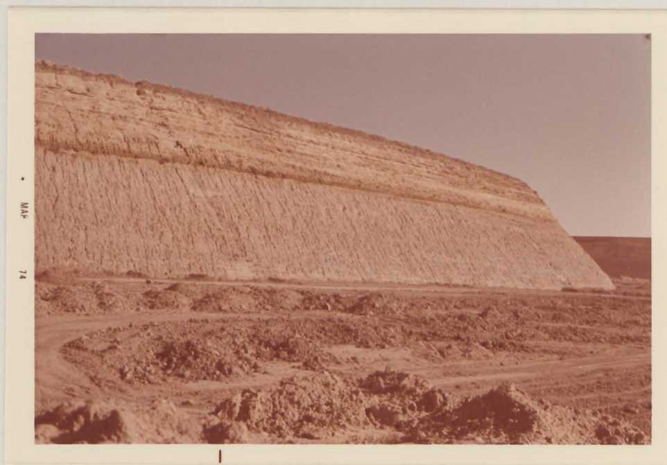
Foto n.10 - Scavi sulla Marana Capacciotti in località Posta Barone Grella. Contatto tra la serie argillosa (Qa) e quella sabbiosa (Qs).
