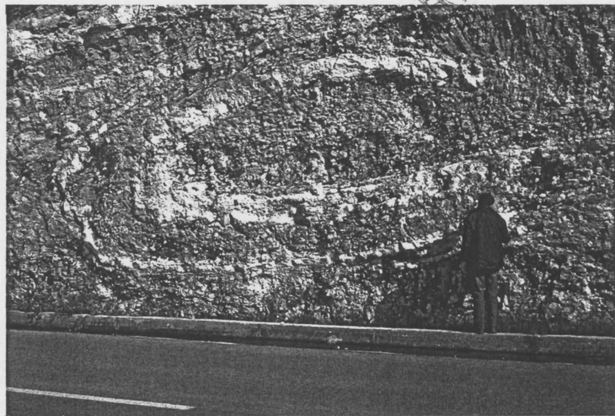
Foto n. 2 - Fenomeno di "slumping" sulla strada costiera a Sud-est del padule di Sfinale.
