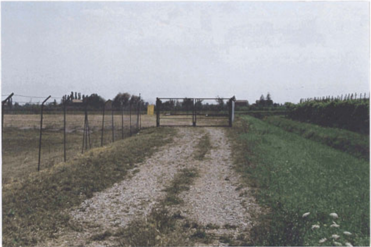
1. Vista dell'accesso alla postazione
